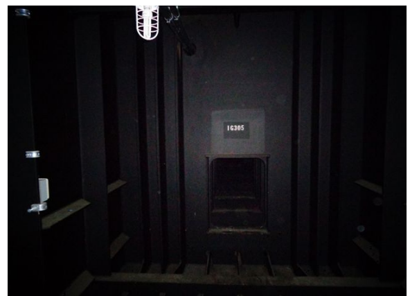
주형 내부전경 (지점부 교각)
